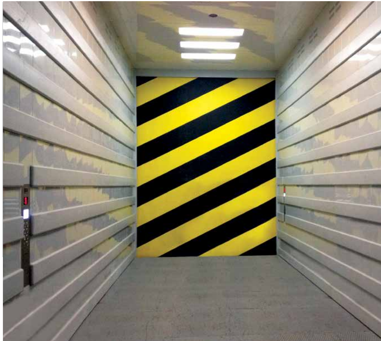
Custom-made Hydraulic Freight Lift 3,6 m wide x 8m depth x 4,7 m height Изготовленный на заказ гидравлический грузовой лифт: ширина 3,6 м x глубина 8 м x высота 4,7 м
