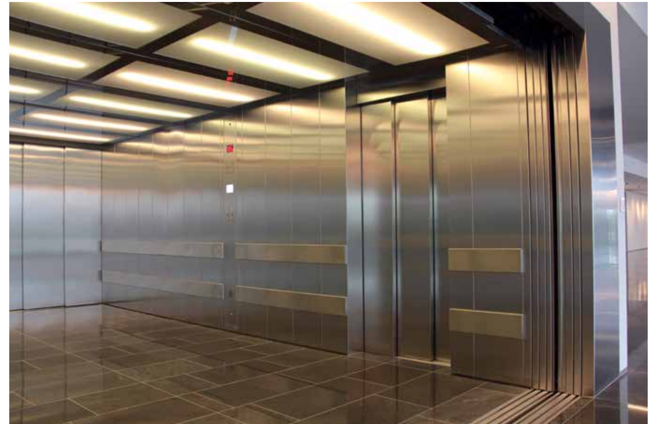
AutoLift (double piston and rated load 4.800 kg) with 3rd entrance on the side Автомобильный лифт (2 гидроцилиндра, грузоподъемность 4800 кг) с третьим выходом на боковой стенке
