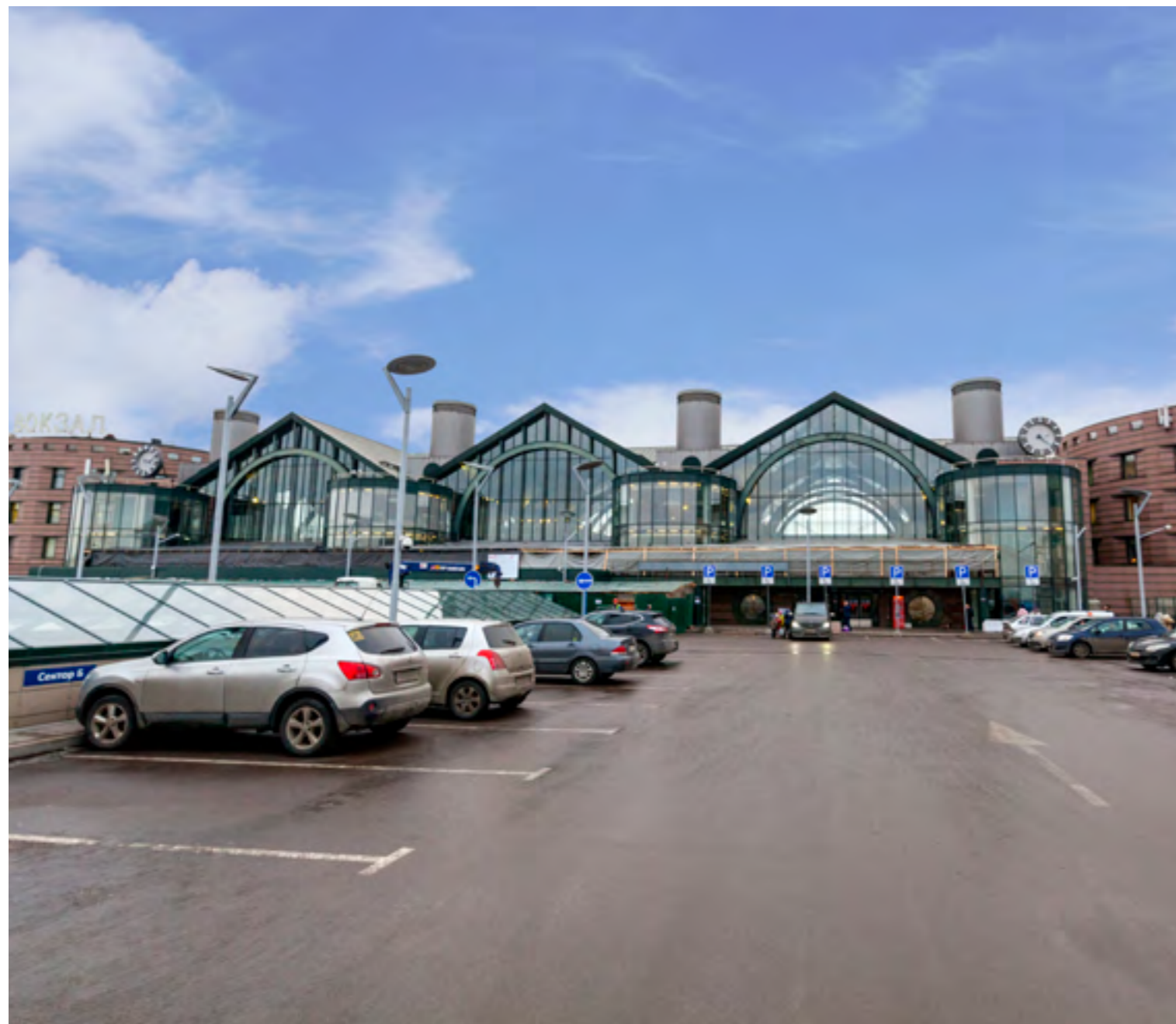
Ладожский вокзал, Санкт-Петербург
